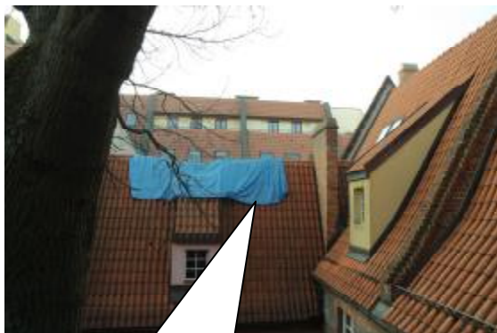
WIDOK OD DZIEDZIŃCA ZAKRES USZKODZENIA PO POŻARZE
